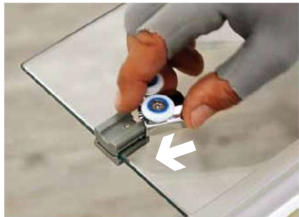
5 INSTALLAZIONE PORTE Il montaggio del carrello e del sistema di sgancio si effettuano senza l'ausilio di attrezzi
