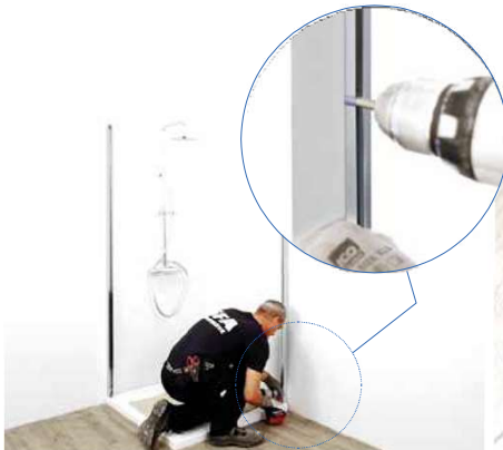
1 FISSAGGIO A MURO DEI PROFILI Questa è l'unica fase che prevede l'utilizzo di un avvitatore
